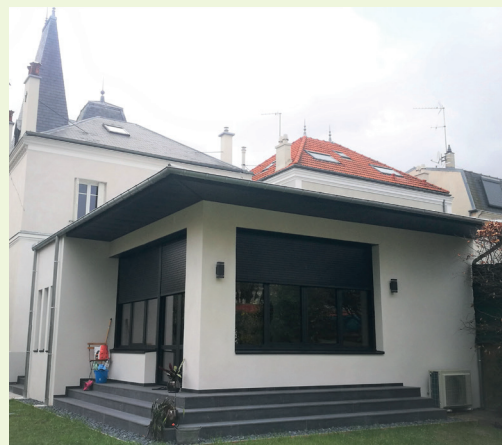
Extension arrière permettant de profiter pleinement du jardin. Extension à Bois-Colombes
