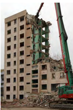
Démolition du 38, rue Armand-Lépine
