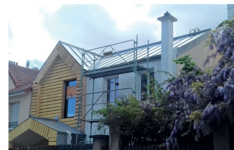
Mode constructif : il a opté pour une extension en «structure bois» pour ce pavillon de taille modeste à l'origine. Bois-Colombes.
