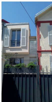
L'art de la liaison : extension latérale sur deux niveaux respectueuse des volumétries du pavillon existant tout en jouant sur un effet de rupture. Bois-Colombes.
