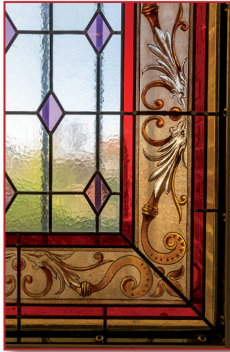
Frise, de la verrière de l'escalier principal, composée d'un motif à têtes animalières
