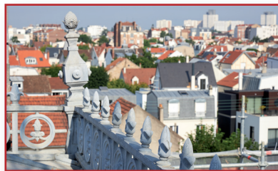
Crête de toit et épi de faîtage en zinc
