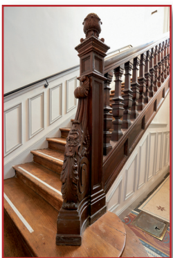
Escalier principal à la française
