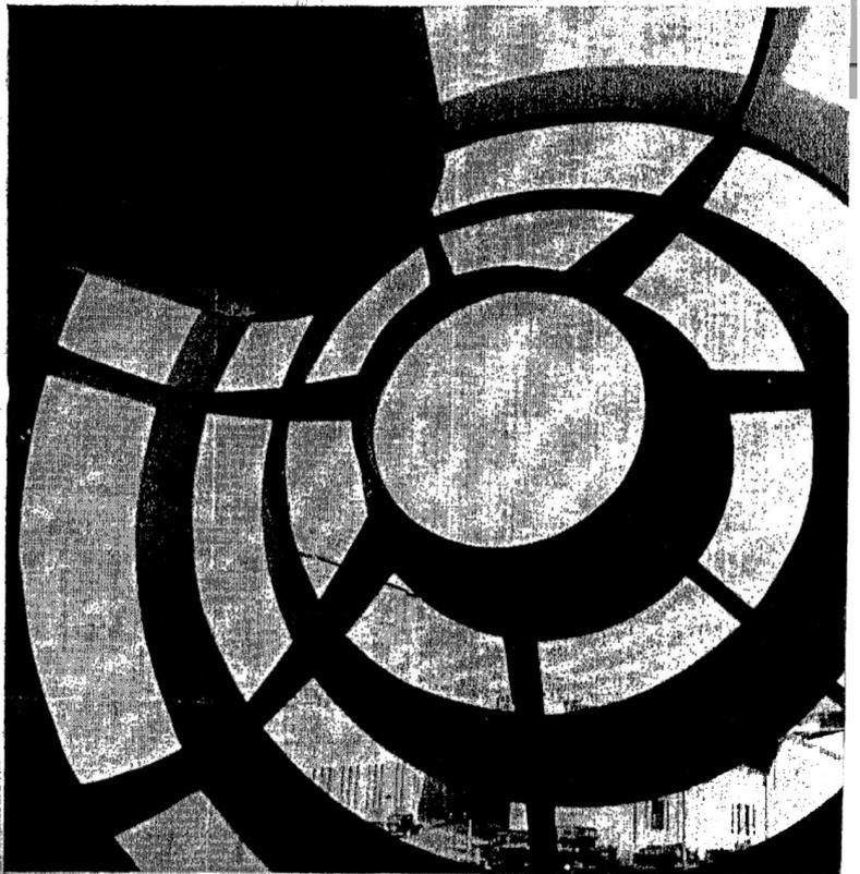
Ci-dessus : le diffuseur de 15 mètres de diamètre à la sortie de la soufflerie Hispano Suiza.
