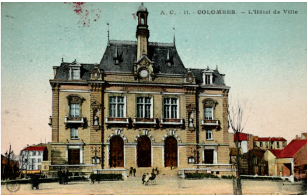
La façade principale de l’hôtel de ville de Colombes, années 1920 (Archives départementales des Hauts-de-Seine)
