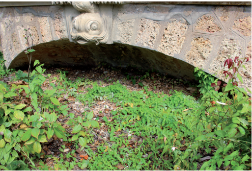
Sous la terrasse de la façade principale du château des Tourelles, une voûte en demi-berceau en pierre meulière (Ville de Bois-Colombes/Direction de la communication)
