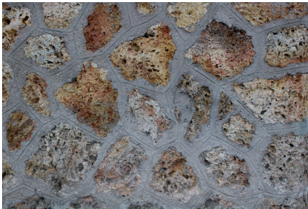
Soubassement du château des Tourelles en pierre meulière (Ville de Bois-Colombes/Direction de la communication)
