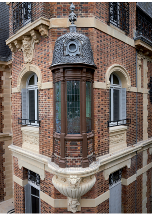
Le toit à l'impériale du bow-window associe ardoise en écaille, oeil-de-bœuf et épi de faîtage en zinc (Studio des Bourguignons/Richard Loret)
