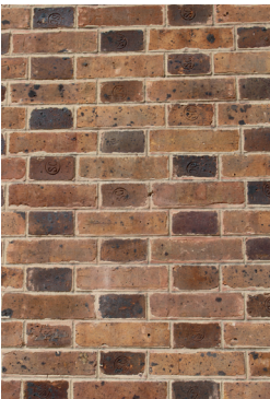
Jeu de couleurs et alternance de boutisses et panneresses sur les façades du château de Tourelles (Ville de Bois-Colombes/Direction de la communication)
