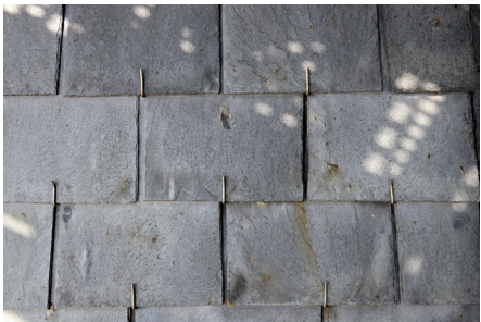
Rangées d'ardoises maintenues par des crochets (Studio des Bourguignons/Richard Loret)
