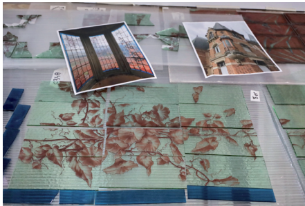
Restauration d'un panneau en partie lacunaire du vitrail du bow-window par les Ateliers Duchemin (Studio des Bourguignons/Richard Loret)
