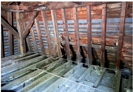
Alternance de voliges et de liteaux dans les combles du toit mansardé du château des Tourelles (Studio des Bourguignons/Richard Loret)
