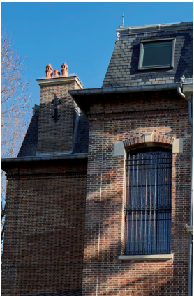
Ornements en brique sur la façade est du château des Tourelles : frise sur la partie haute de façade et appareil de briques en arc sur le linteau de la fenêtre de l'escalier principal (Studio des Bourguignons/Richard Loret)
