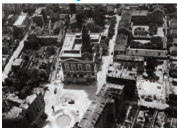
Au 1 er semestre de l'année 1937, les travaux de l'hôtel de ville se terminent. Le percement de la future rue Félix-Braquet, l'aménagement de la place de la République et la construction de l'école maternelle Paul-Bert sont en cours (AMBC)
