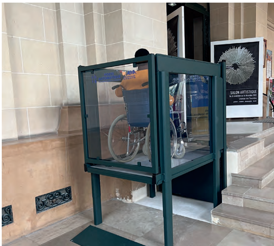
Monte-personne installé à l'hôtel de ville, pour permettre aux personnes à mobilité réduite d'accéder plus facilement à l'accueil de la mairie
