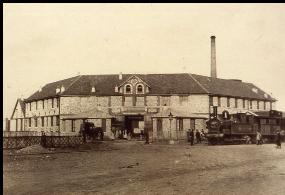
L'usine Guerlain installée rue du Parc à Bois-Colombes, début du 20 e siècle (AMBC)
