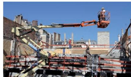
**Sept. 2010.** L'ancienne charpente a été déposée et les gradinages de la salle commencent à s'édifier.
