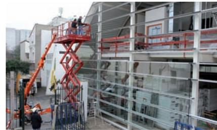
**Fév. 2011.** La pose de l'enveloppe du bâtiment commence avec les panneaux de verre fixés sur la structure d'acier.
