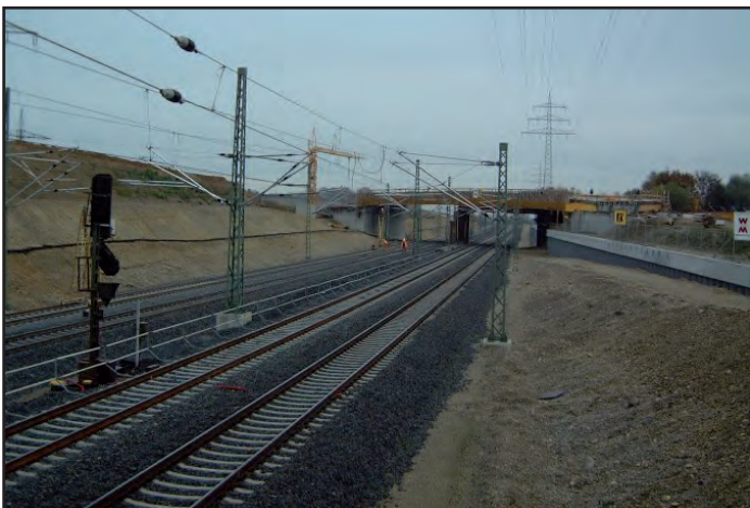
Abaissement des installations ferroviaires liée à l'aménagement des lignes à grande vitesse de l'ICE entre Stuttgart et Munich.
