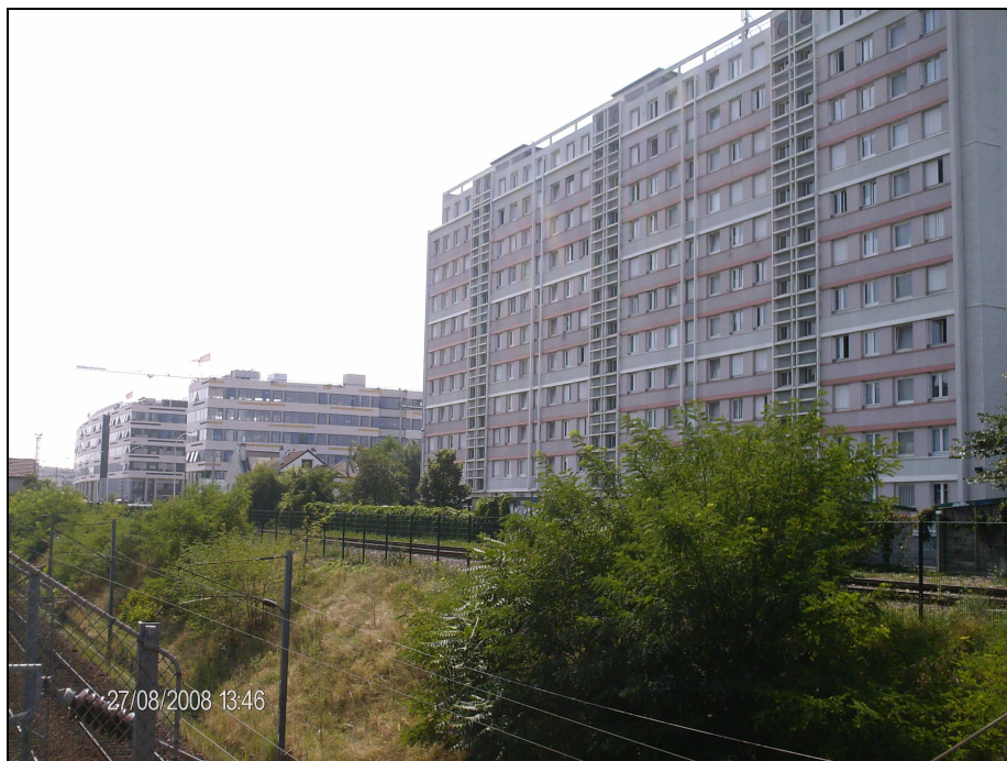
Le long des voies ferrées, un panorama en devenir
