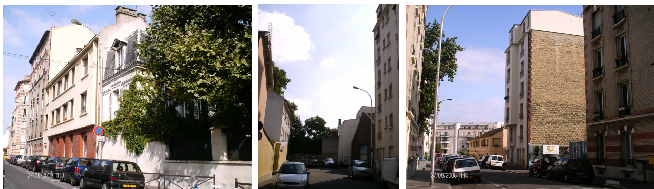
Photos 3) 4) et 5), un bâti disparate avec d'importantes rupture d'échelle formant « dents creuses »
