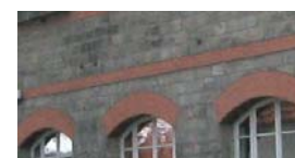
Bandeau en brique sur façade en pierre
