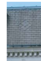
Motif de toiture
