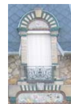
Bandeau en brique sur façade en pierre
