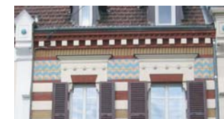
Bandeau en céramique sur façade en brique
