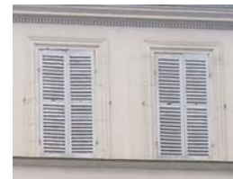
Bandeau et encadrement de plâtre, aux formes légèrement irrégulières
