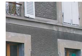
Bandeau et encadrements en ciment, crépi ajouté : à éviter
