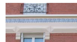
Bandeau en céramique sur façade en brique
