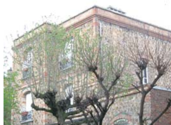
Toit terrasse, rare sur les constructions anciennes
