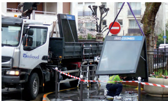
Installation des nouveaux panneaux lumineux d'information en mars 2016
