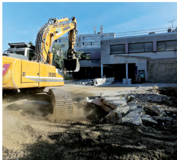
Début des travaux de l'école Saint-Exupéry en septembre 2016.
